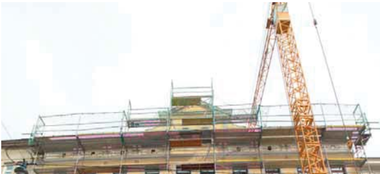
Stahlrohrgerüst als Arbeitsgerüst und Fanggerüst für Dacharbeiten mit Schutznetz als Seitenschutz und Sicherung im Giebelbereich
