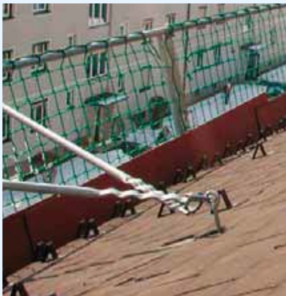
Stabile Dachschutzblenden, rückverankert und gegen Ausheben gesichert
