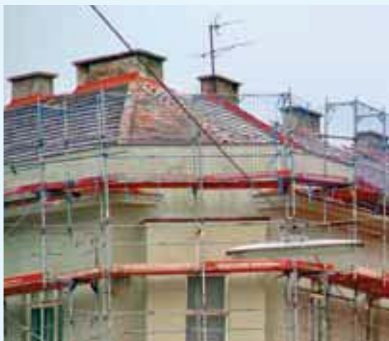
Stahlrohrgerüst als Dachfanggerüst mit Seitenwehren und Schutznetz
