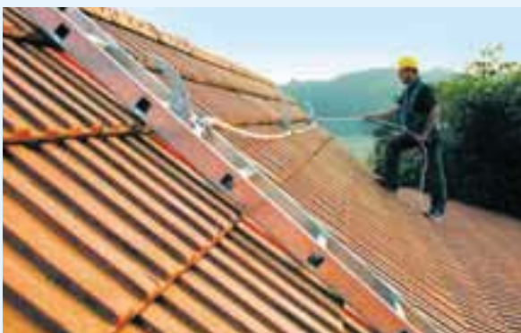
Aufstieg und Anseilschutz über geprüfte Dachhaken
