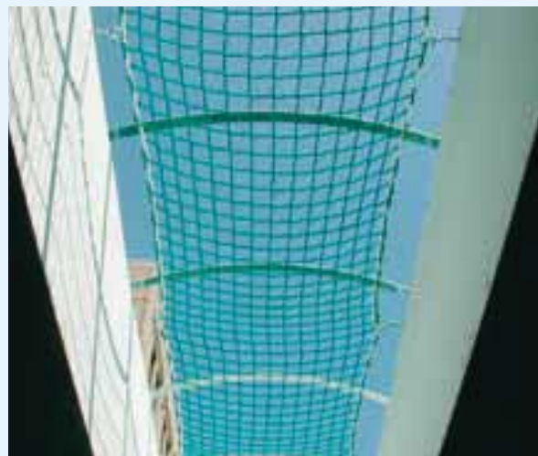
Sicherung einer Oberlichte
