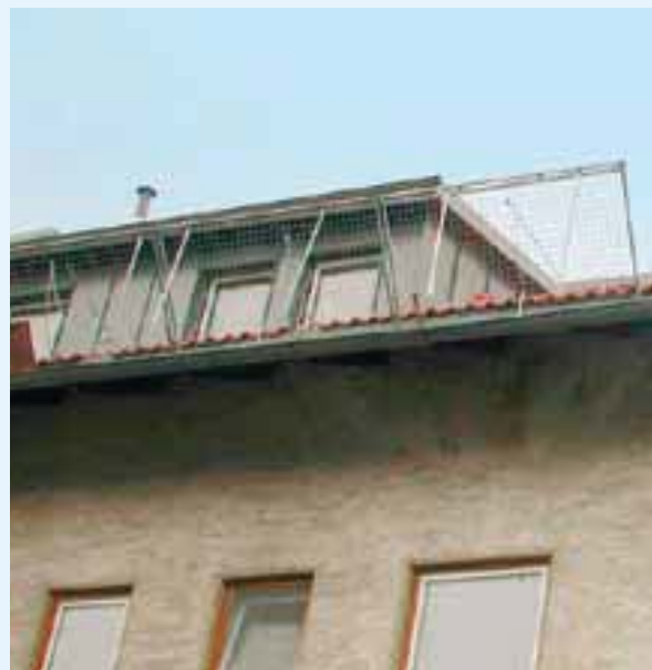
Stabile Dachschutzblenden, rückverankert und gegen Ausheben gesichert
