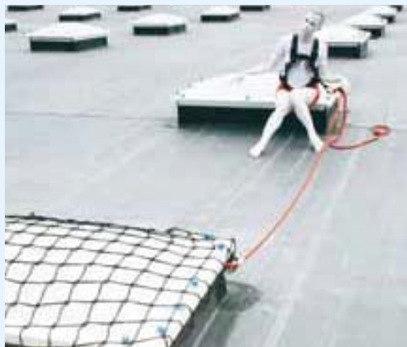
Sicherung von Dachöffnungen
