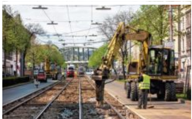
Schon seit Ende März wird in der Hernalser Hauptstraße gearbeitet
